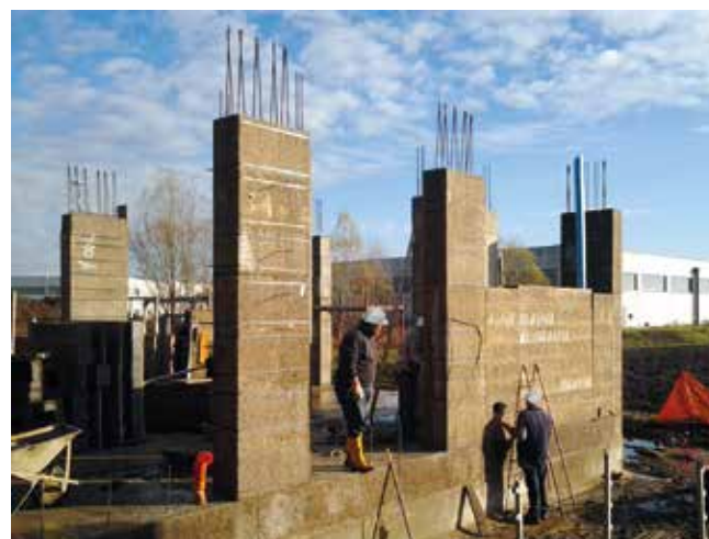
STUP 25cmx25 cm s izolacijom na tri strane od 5cm EPS-a s GRAFITOM + 3,5 drvobetona
